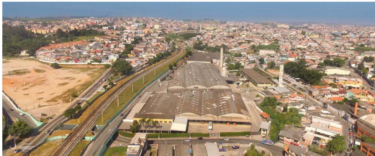
Vista aérea da sede própria da Nambei, localizada em Ferraz de Vasconcelos/SP, com 49.000m²
